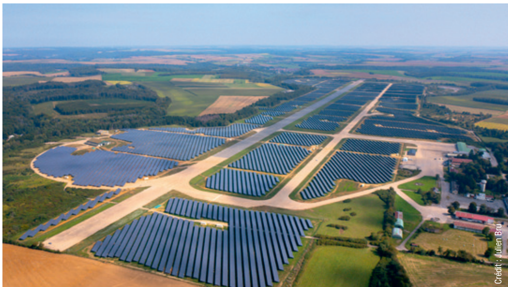
La centrale photovoltaïque de Marville, construite sur un aéroport en activité, couvre 155 hectares et équivaut à une puissance installée de 152 MWc. Elle produit dans sa totalité 160 GWh par an soit l'équivalent de la consommation annuelle de 23 000 habitants.
